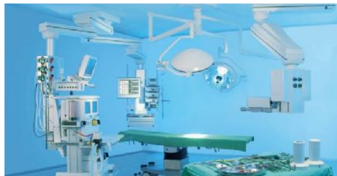
Deckenversorgungseinheiten
